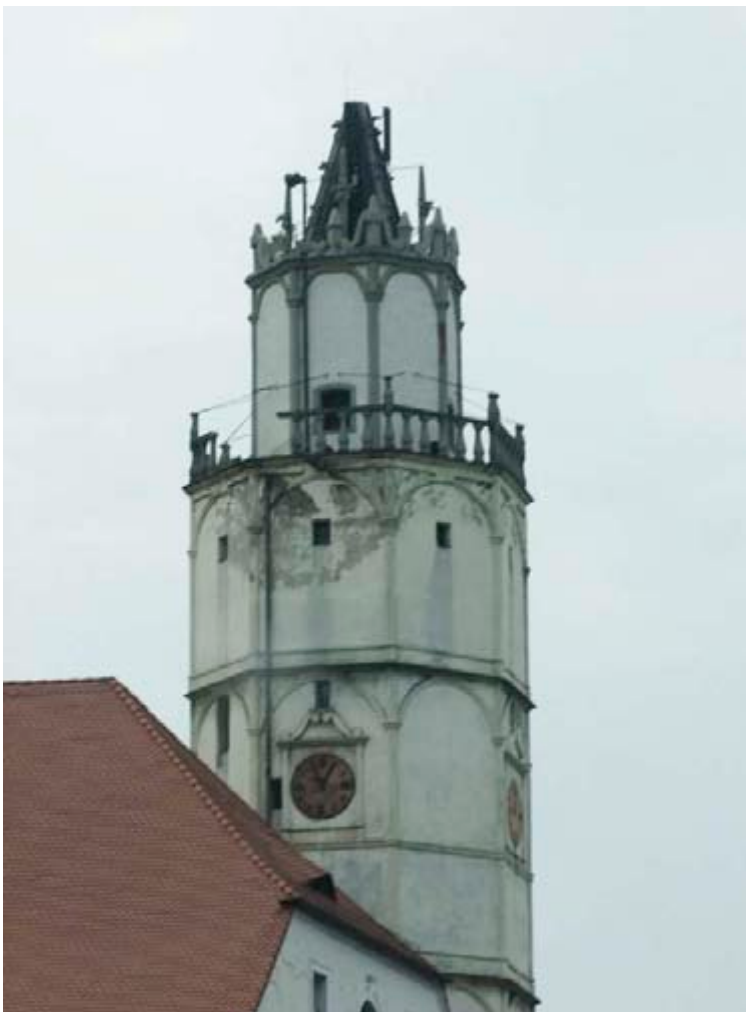
Wieża renesansowego ratusza w końcu doczeka się remontu.
