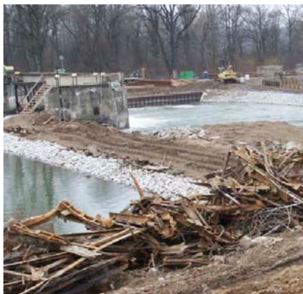
Tama wojskowa w trakcie rozbiórki
