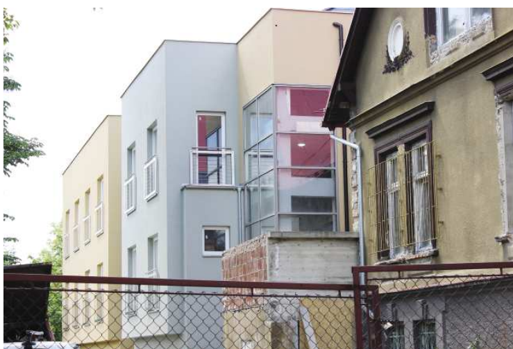
WEWNĄTRZ PAWILONU ŁÓŻKOWEGO TRWAJĄ PRACE, A STARE PRZEDSZKOLE PRZY ZDROJOWEJ JEST W REMONCIE
